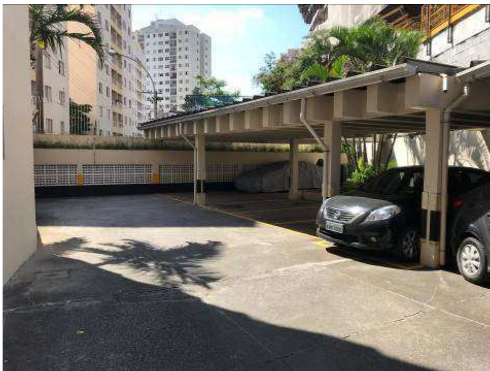
Vista parcial das vagas de garagem situadas no pavimento térreo.
